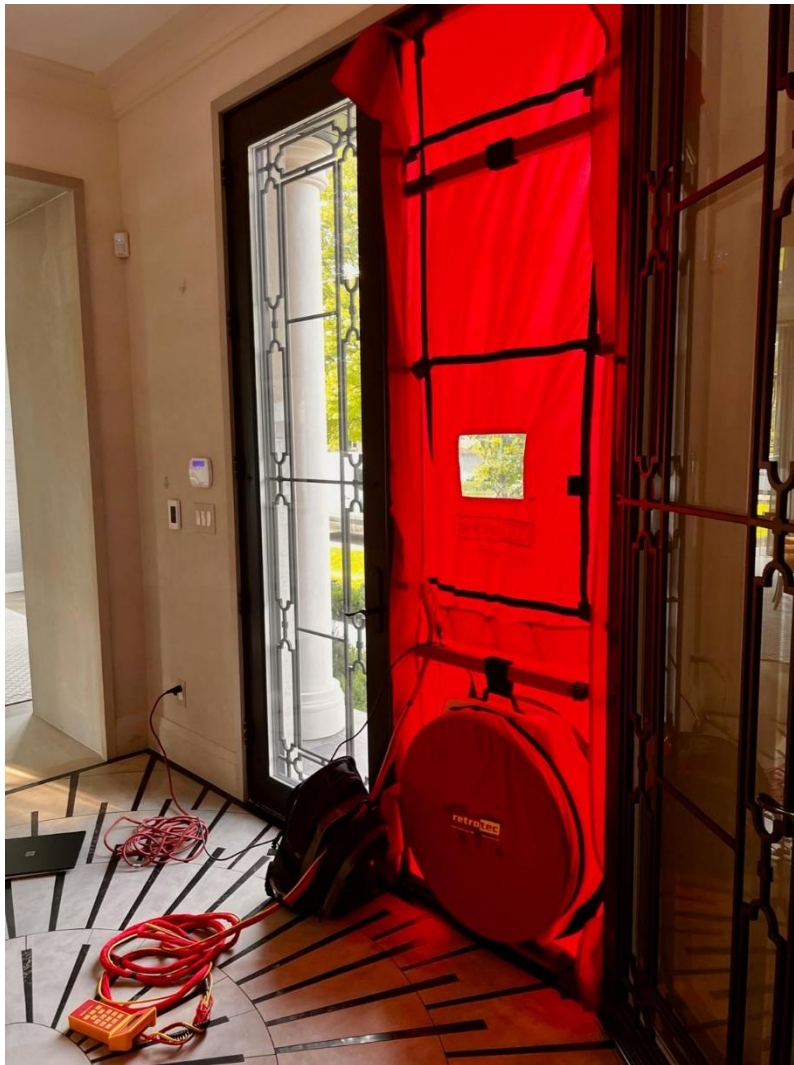
Blower door test.
